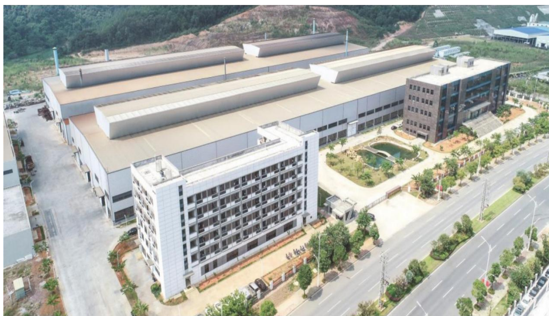
广东金志利科技有限公司（建筑面积：60000m 2 ）
