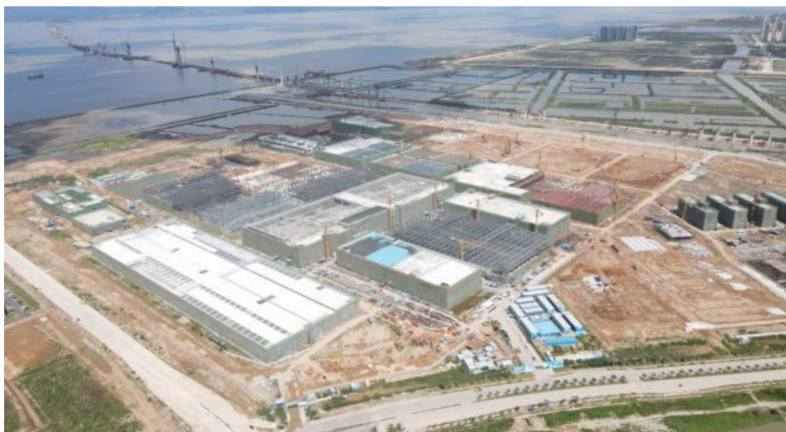
珠海格力高端电器（高栏）产业园项目注塑车间钢构（用钢量 11000 吨）
