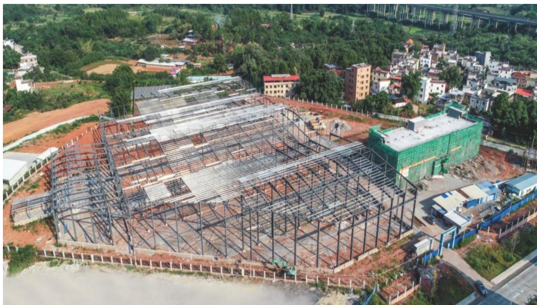
广东顺泰智慧城（建筑面积：17000m 2 ）
